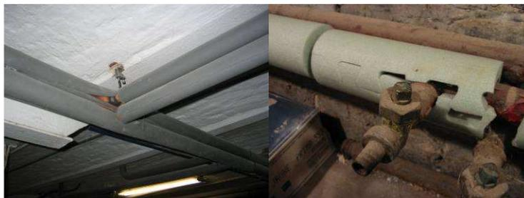
**Figure 10.6: calorifuge de tuyaux de chauffage**
