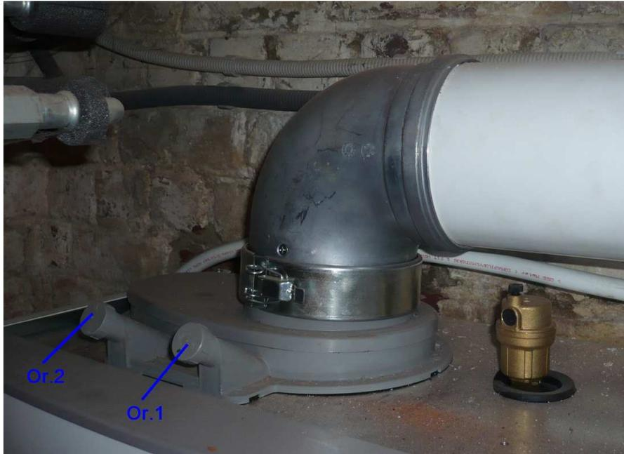
Figure 4.2: Montage réel d'orifices de mesures
